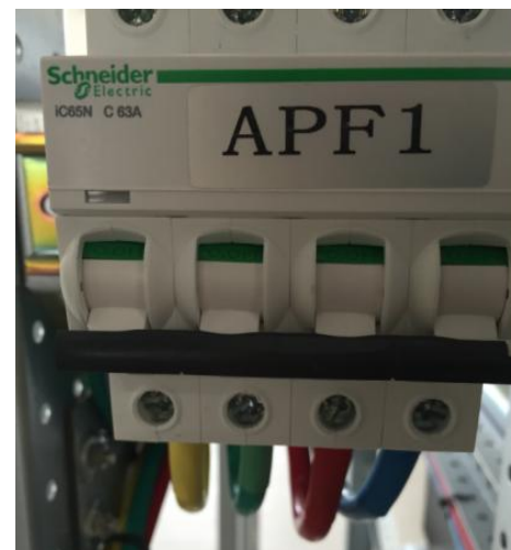
图 2-11 主进线端子接线示意
